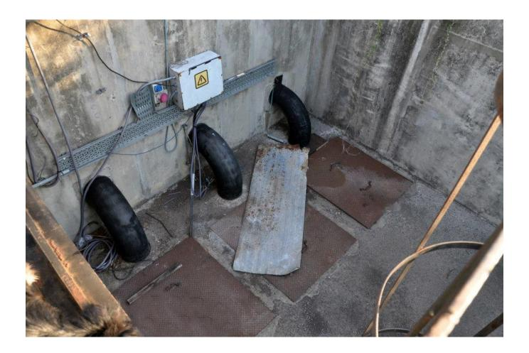
2- Como podrán constatar en las 3 imágenes siguientes, la única bomba operativa es la del medio, ya que la de la derecha se encuentra completamente desconectada del circuito de alimentación eléctrico, y a simple vista la bomba de la izquierda presenta sus 2 cables de alimentación "Sintenac" de 6 mm desconectados y atados precariamente a la bandeja porta cable.
